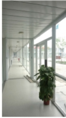
图 2：单排外走廊封闭
